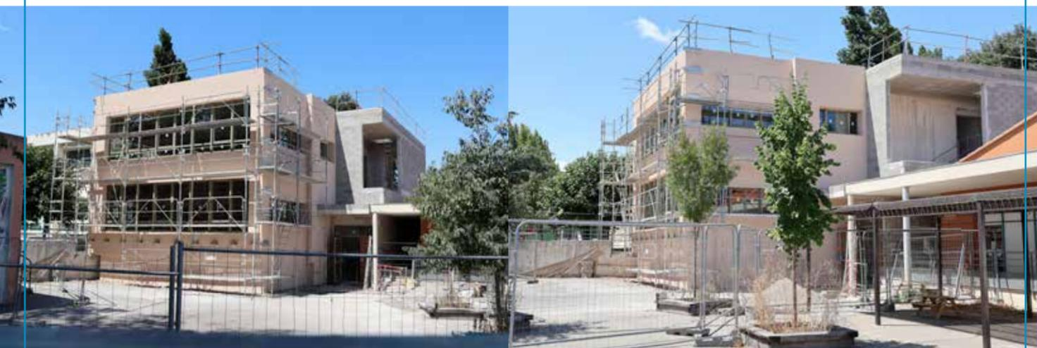
La réhabilitation de la cage d'escalier de l'école avance à grands pas et laisse déjà entrevoir les contours de la future Val Seille. Après les phases de démolition, la réalisation des micro-pieux et la pose des poutres métalliques assurant la solidité de l'ouvrage, les travaux de maçonnerie sont désormais achevés.
