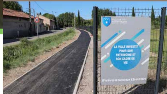
Les travaux d'aménagement de la nouvelle voie de cheminement doux piétons et cycles allant de la résidence Le Ventoux jusqu'à la gare, sont terminés ! Les enrobés ont été coulés, les marquages au sol réalisés et les clôtures reposées.
