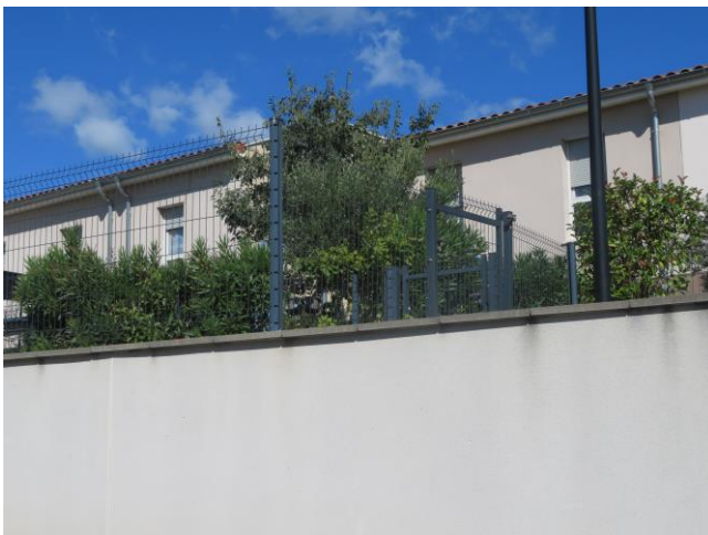
Les doubles clôtures de certains lotissements ou résidence : une clôture autour de l'ensemble et des clôtures autour de chaque jardin. Les murs hauts sont également à proscrire.
