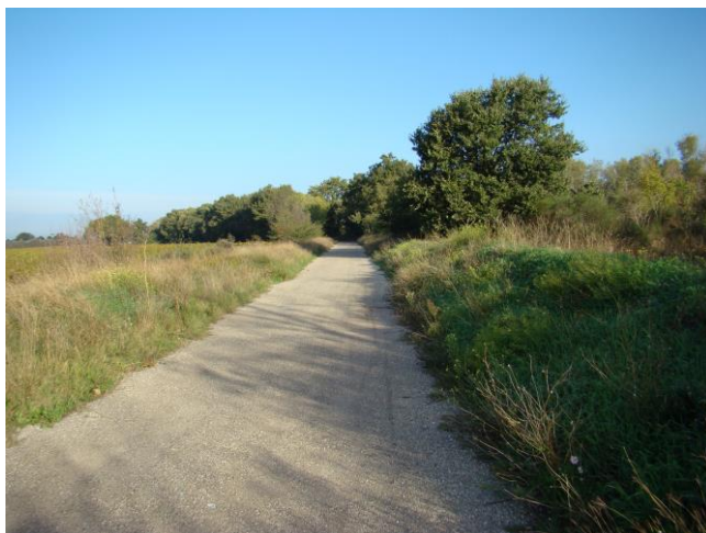
Voie douce le long de la ripisylve de l'Ouvèze en rive droite
