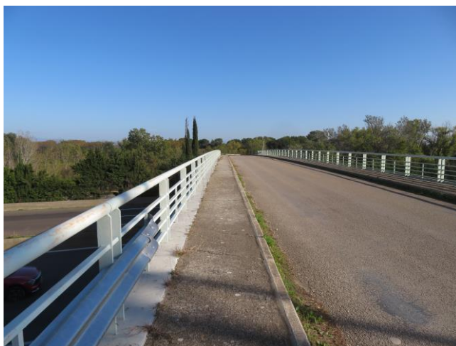
Pont au-dessus de l'autoroute et de la RD907 à l'extrémité sud de la commune
