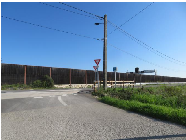
Mur anti-bruit le long de l'autoroute à l'ouest de la commune
