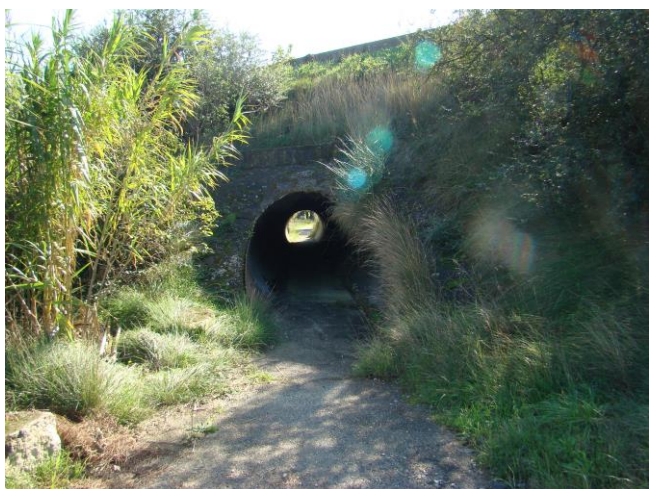
Passage sous la RD950
