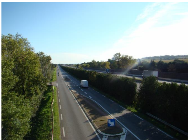
Linéaire formé par l'autoroute du soleil et la RD907 et cloisonnant la commune du nord au sud
