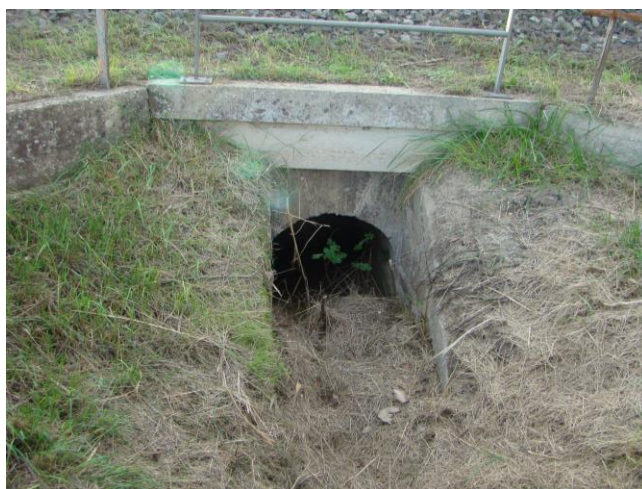
Passage sous la voie ferrée
