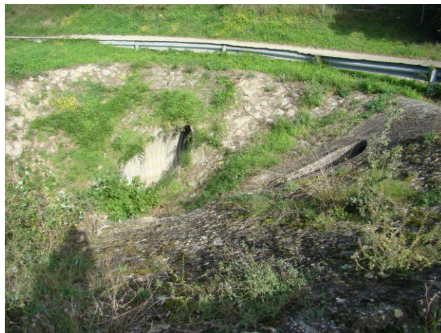
La Grande Mayre : busage sous l'autoroute
