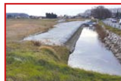
Orange, Bassin écrêteur de crue de la Meyne
