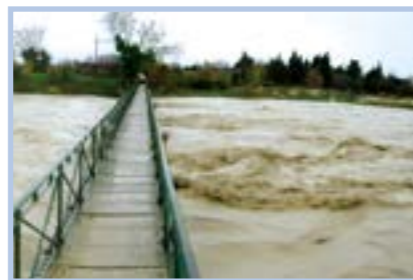
Orange, crue torrentielle, Aygues, 11/2002
