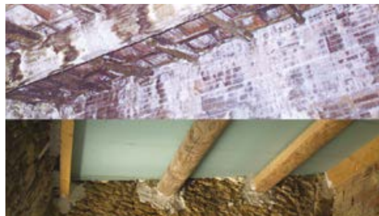
Etat de sous-toiture, avant et après travaux, dans le cadre de la 1 ère OPAH intercommunale.
