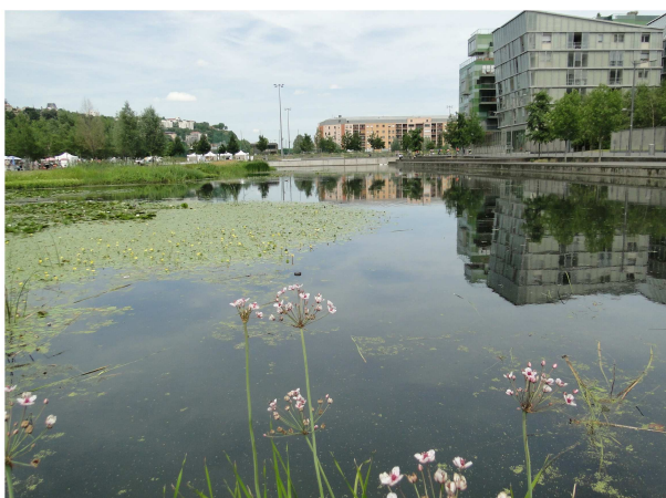
Bassin rétention, infiltration en eau Confluences Lyon
