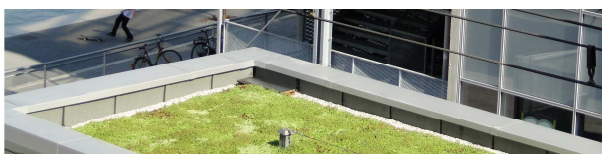
Toiture végétalisée Confluences Lyon
