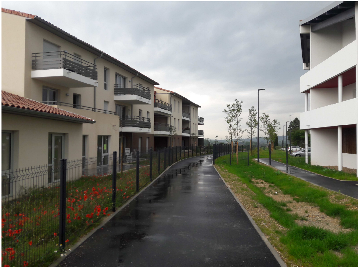
Cheminement piéton quartier de la Barrade Nord
