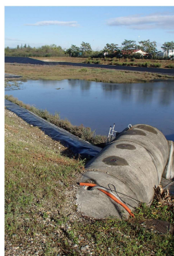
Bassin de rétention Chassieu
