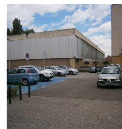
Chaussée réservoir Villeurbanne
