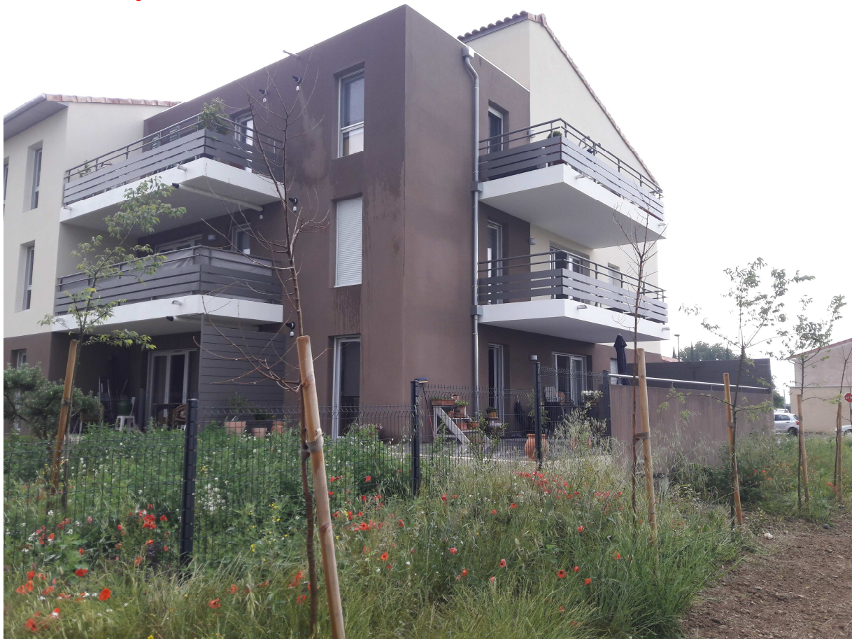
Exemple : Logements collectifs quartier de la Barrade Nord
