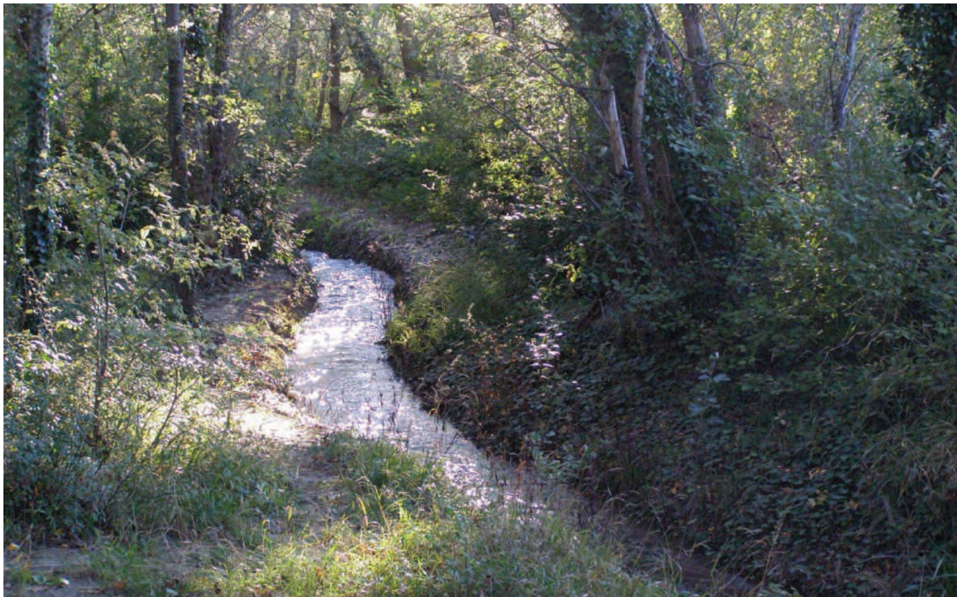
Un réseau hydrographique complexe entre canaux d'irrigation et de drainage et nombreuses rivières
