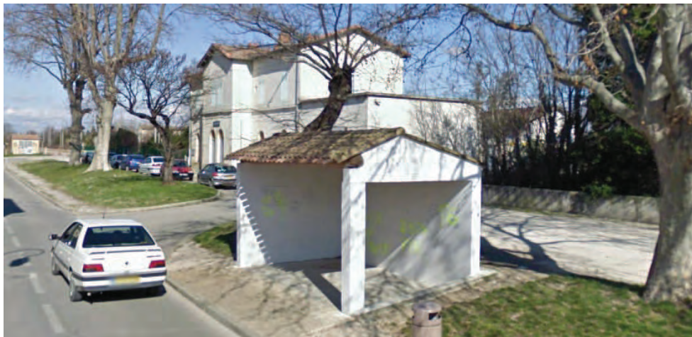
Un pôle gare / transports en commun à renforcer et "recentraliser"
