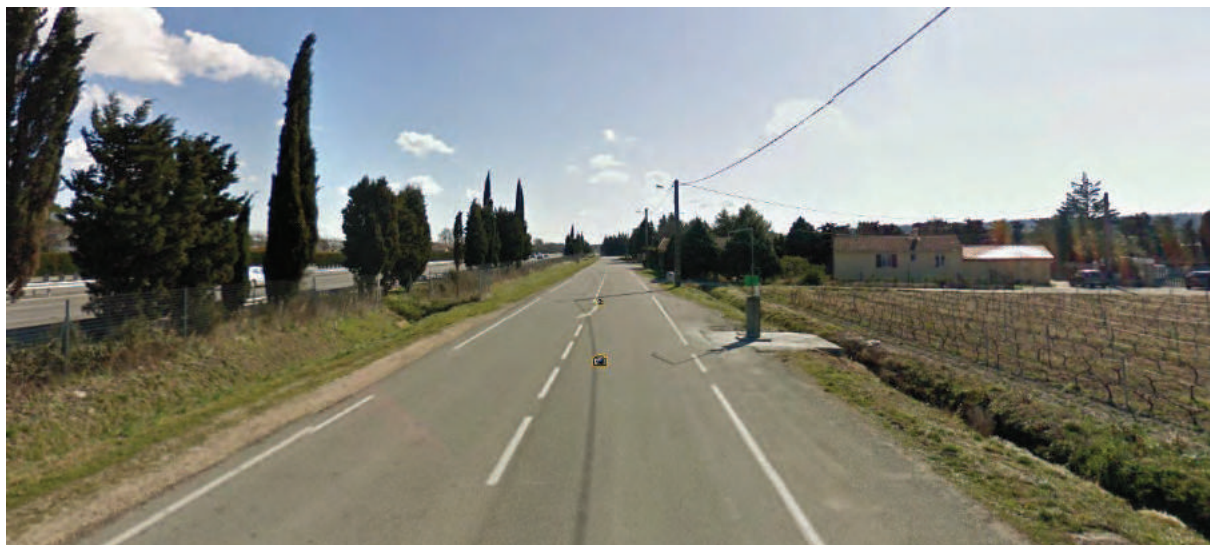
Route de Châteauneuf-du-Pape : une configuration peu urbaine propice aux dépassements de vitesse
