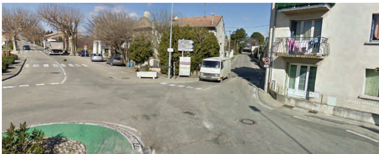
Le rond point de Conil, à l'intersection de la Route de la Plaine, Av des Anciens Combattants, Fbg de Luynes et Bd Pasteur, assure la desserte de tous les quartiers Nord et le transit Nord/Sud. Un carrefour pourtant difficile qui a depuis fait l'objet d'un réaménagement
